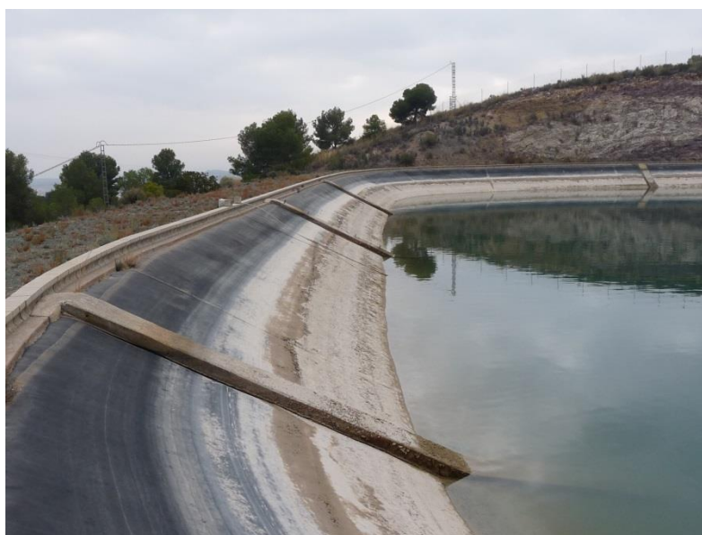
Figure 6. Étanchéité en EPDM sur le réservoir de Mamusa (1997).
