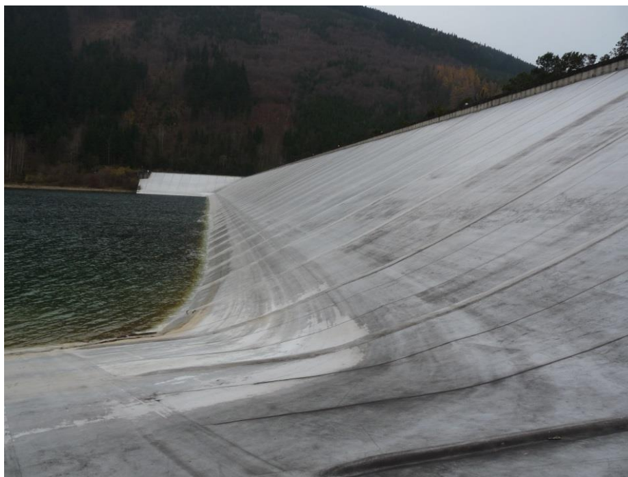
Figure 5. Rénovation en PVC sur le barrage de Moravka (Tchéquie).
